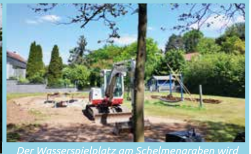
Der Wasserspielplatz am Schelmengraben wird neu gestaltet – und zur Eröffnung schier überrannt
