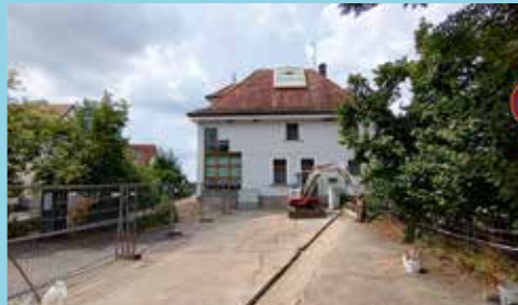
Die Bücherei wird an das Nahwärmenetz von Rathaus und Zenngrundhalle angeschlossen
