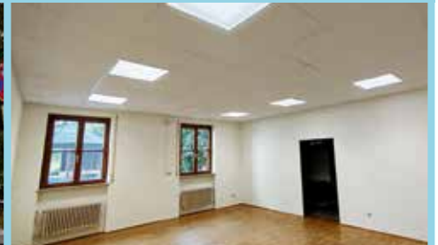
In der Friedrichstraße werden Maßnahmen zur Verbesserung der Akustik durchgeführt
