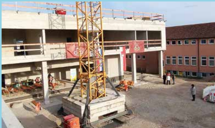
Die neue Kita an der Friedrichstraße kann Richtfest feiern
