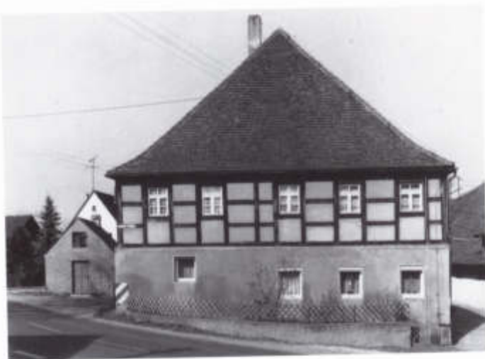
Bernbach, Fürther Straße Nr. 31. Bauernhaus aus dem Jahre 1717 mit Fachwerkobergeschoß und Walmdach (Aufnahme 1984)
