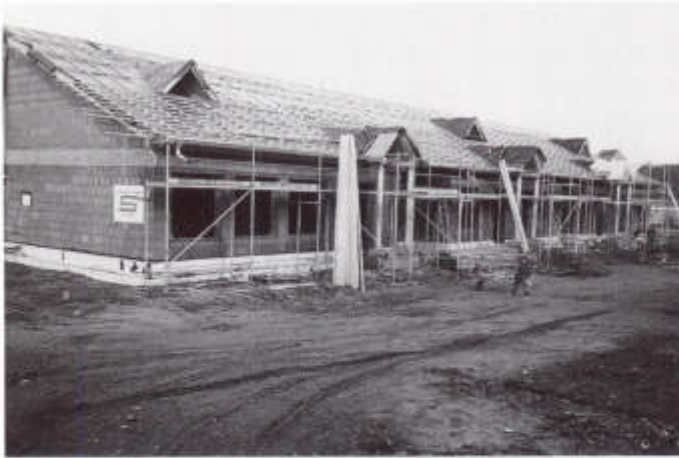
Neuer Gemeindekindergarten wird gebaut. Aufnahme Dezember 1993.
