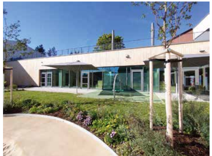
Der Krippenbereich ist in Richtung des früheren Katholischen Pfarrzentrums in den Hang integriert.
